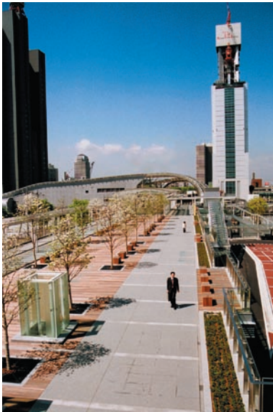
図 2.2-1 F'デッキの東側端部より西側（さいたま新都心駅側）を望む
